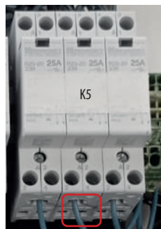
Rys. 94. Podłączenie pompy zaworu mieszającego 1
