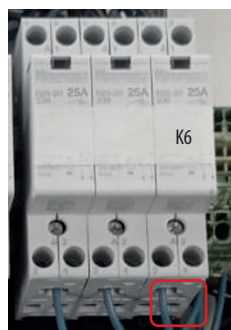
Rys. 95. Podłączenie pompy zaworu mieszającego 2
