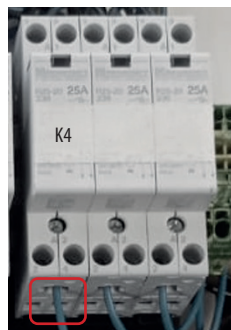
Rys. 93. Podłączenie pompy obiegowej za wymiennikiem płytowym
