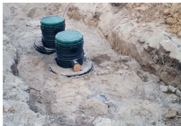
Rysunek 2. Oczyszczalnia actibio podczas montażu.
